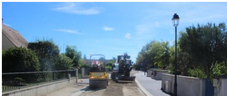
Commune de Montcresson
