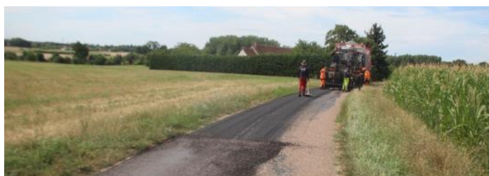
L'entreprise Enroplus en cours intervention
