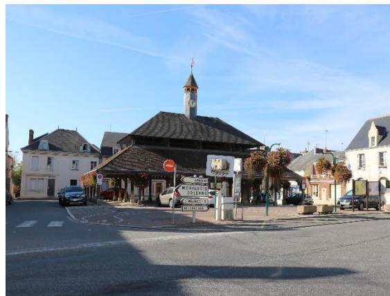
Halle du marché de Ladon
