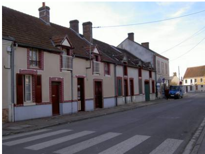
Bâti aligné par rapport à la voie
