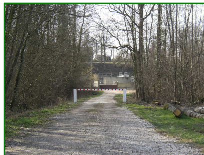
Station d'épuration en fond de vallée
