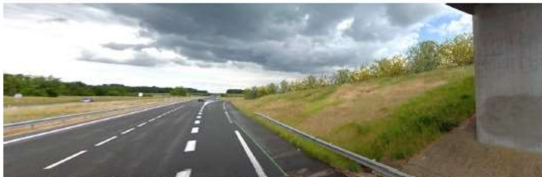
Photomontage 3 : Représentation de la centrale solaire depuis l'autoroute A77 en venant du Sud de Varennes-Changy
