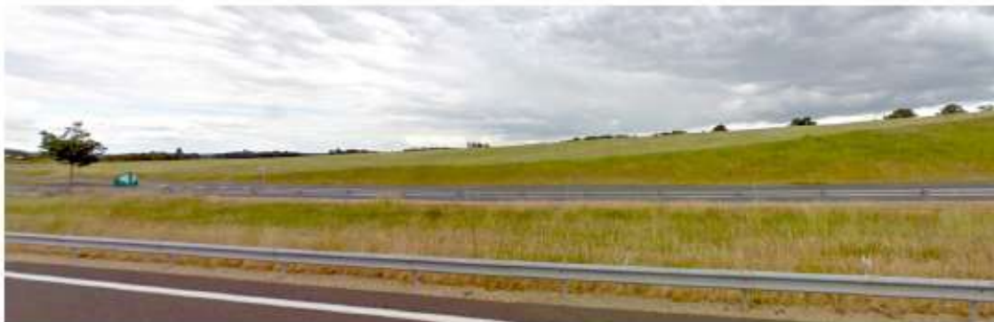
Photo 2 : Vue de face depuis l'autoroute A77 (extrait Google Street View)
